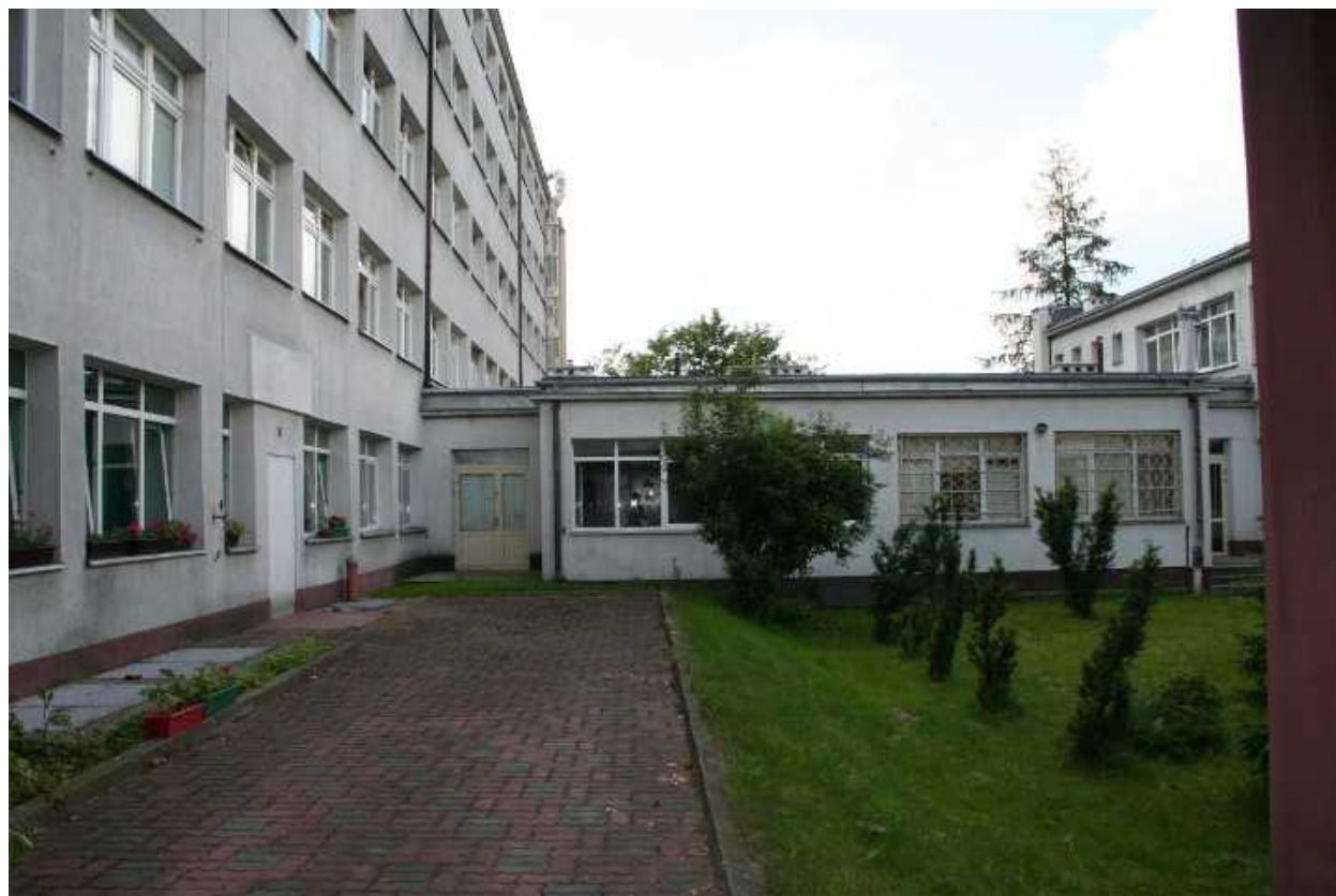
fot.2* Widok łącznika
