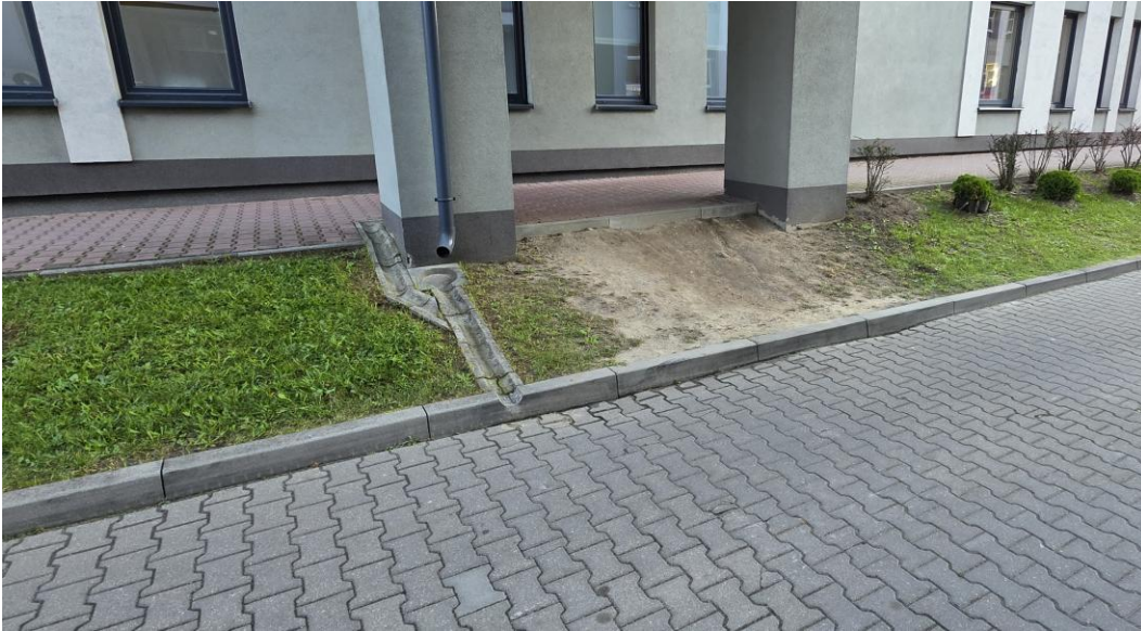
Zdj. 7. Miejsce wykonania schodów wraz ze spocznikiem (lokalizacja nr 5)
