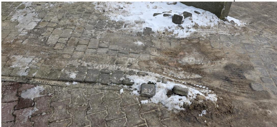
Zdj.11. Miejsce wykonania naprawy chodnika (lokalizacja nr 8)
