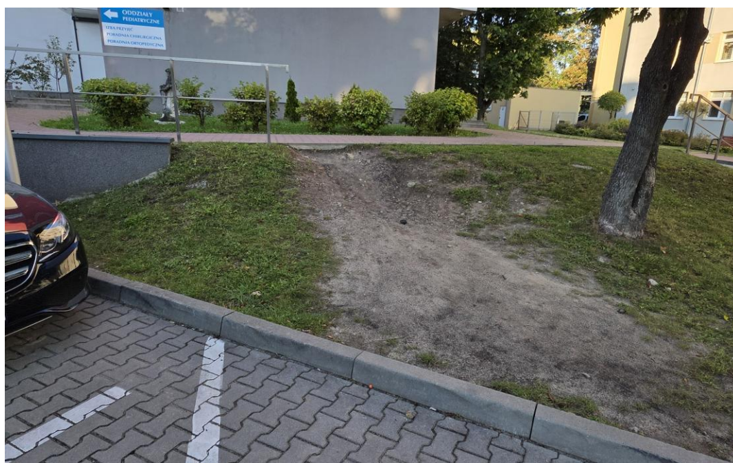
Zdj. 3. Miejsce wykonania schodów wraz chodnikiem (lokalizacja nr 2)
