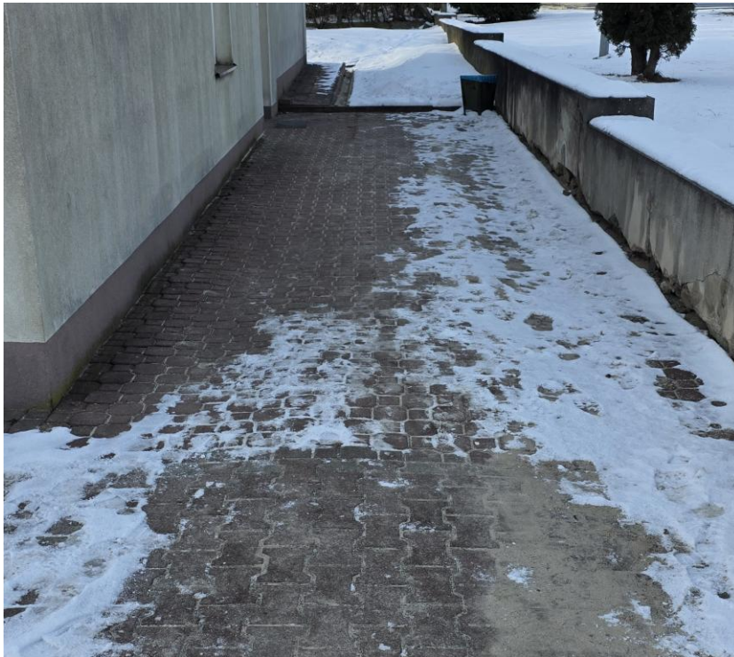
Zdj. 10. Miejsce wykonania naprawy chodnika (lokalizacja nr 7)
