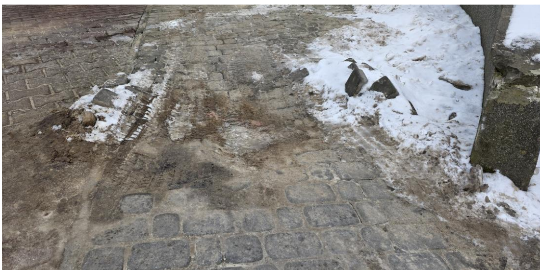
Zdj. 12. Miejsce wykonania naprawy chodnika (lokalizacja nr 8)
